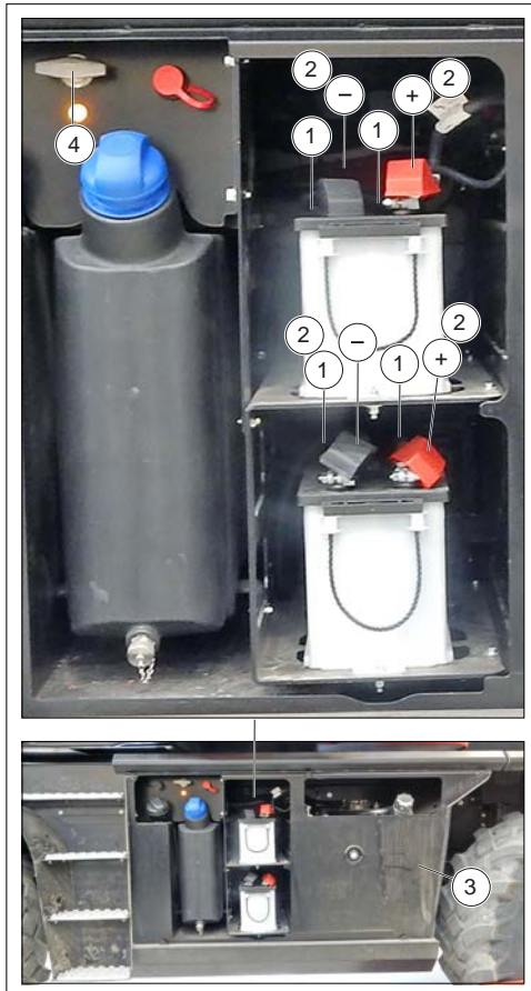
Figure 165: Vérification de la batterie
