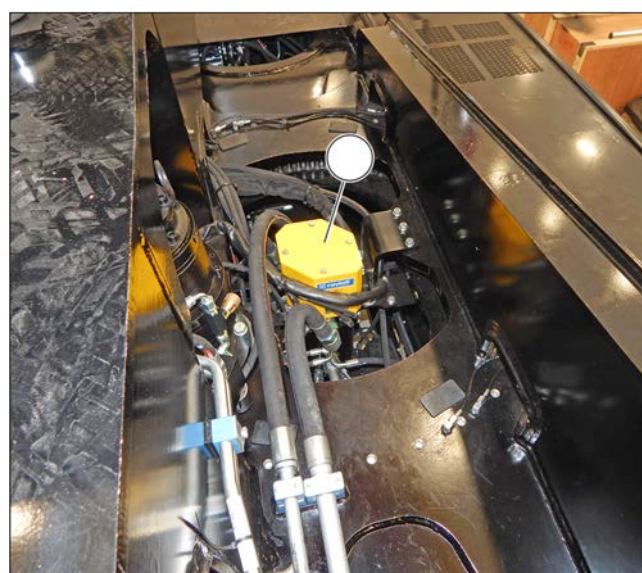
Figure 224: Vérification et nettoyage des bagues émettrices du collecteur électrique rotatif
